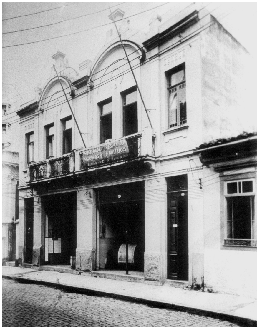
FIG. 12. Fachada da primeira sede da Sociedade Espanhola de Socorros Mútuos. Rua Silveira Martins. São Paulo (SP), s.d.
