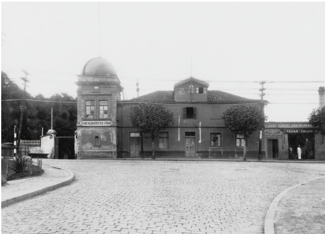
Fachada do Observatório do General Couto de Magalhães, já descaracterizada (Ponte Grande).
