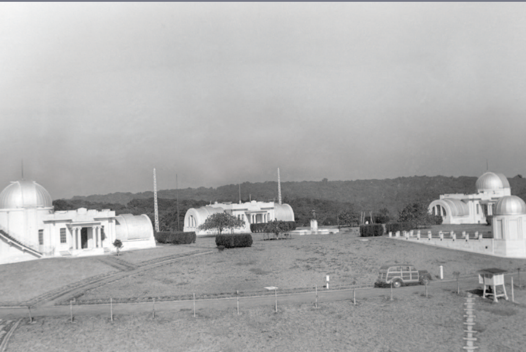
Vista parcial do Observatório Astronômico de São Paulo no Parque do Estado, bairro da Água Funda. Da esquerda para a direita: o Pavilhão Cooke, que abriga o refrator Zeiss de 175mm; o Pavilhão de Serviço Meridiano e o Pavilhão Fotográfico que abrigava o refrator Grubb de 200mm. No primeiro plano: Pavilhão Heliográfico.
