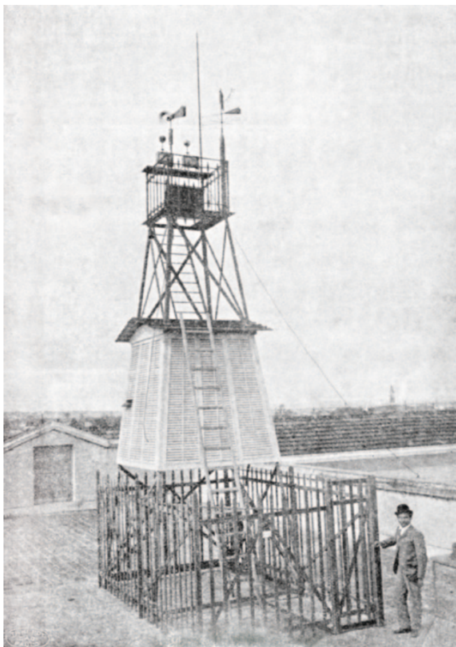
Estação Meteorológica Central do Serviço Meteorológico da Comissão Geográfica e Geológica de São Paulo, sobre o telhado da Escola Normal da Praça da República (1895-1912).
