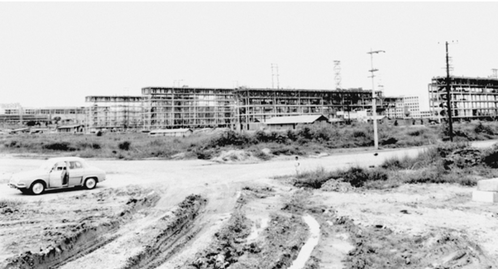
Construção do Conjunto Residencial da USP
