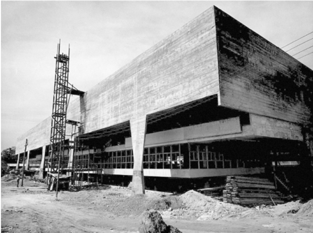
Finalização das obras da Faculdade de Arquitetura e Urbanismo
