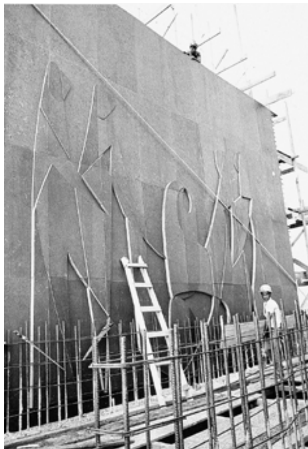
Montagem da Torre do Relógio
