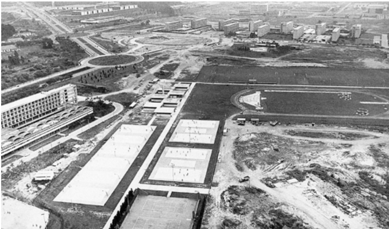
Construção do Centro de Práticas Esportivas da USP
