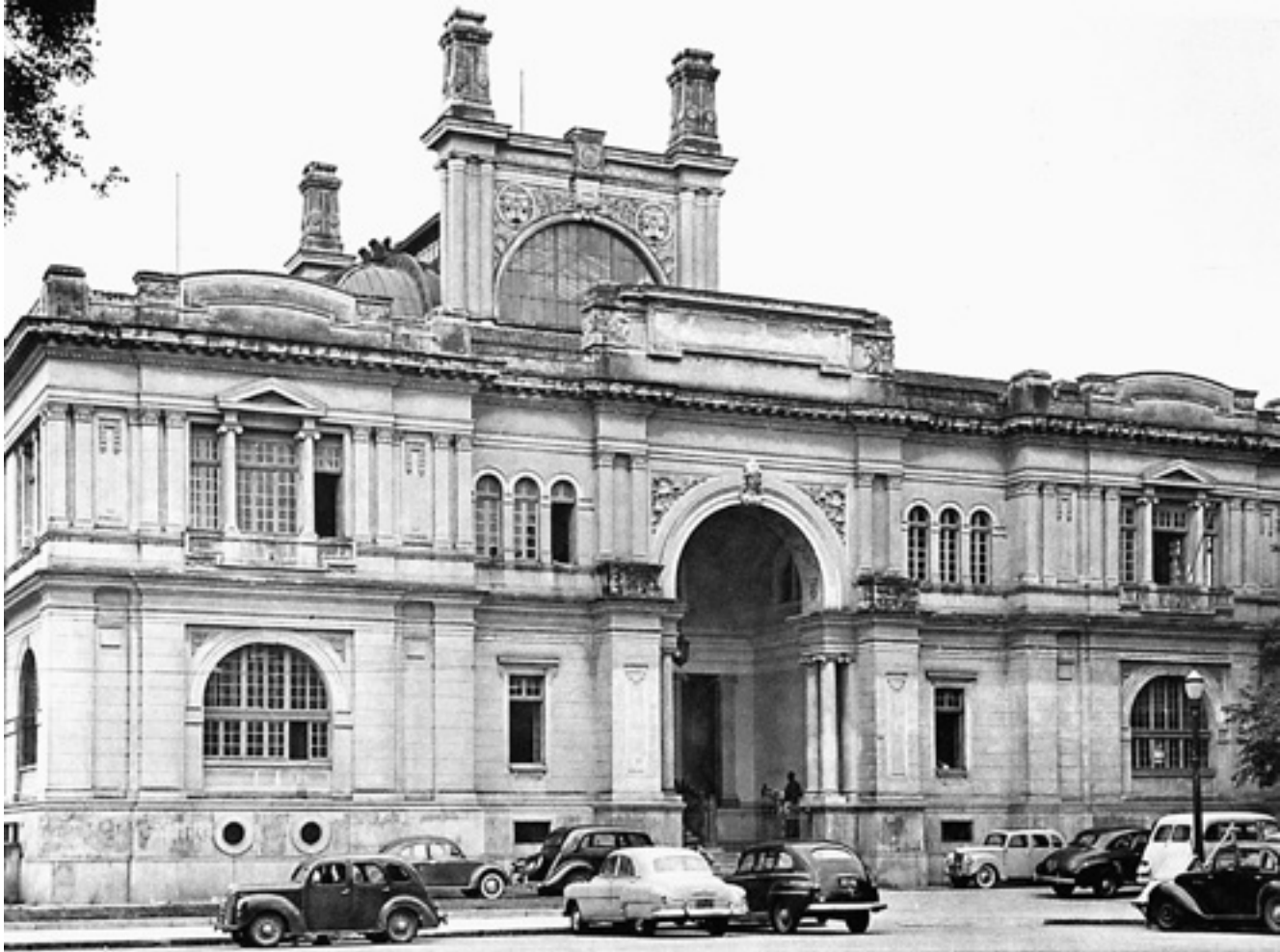
Edifício Ramos de Azevedo da Escola Politécnica
